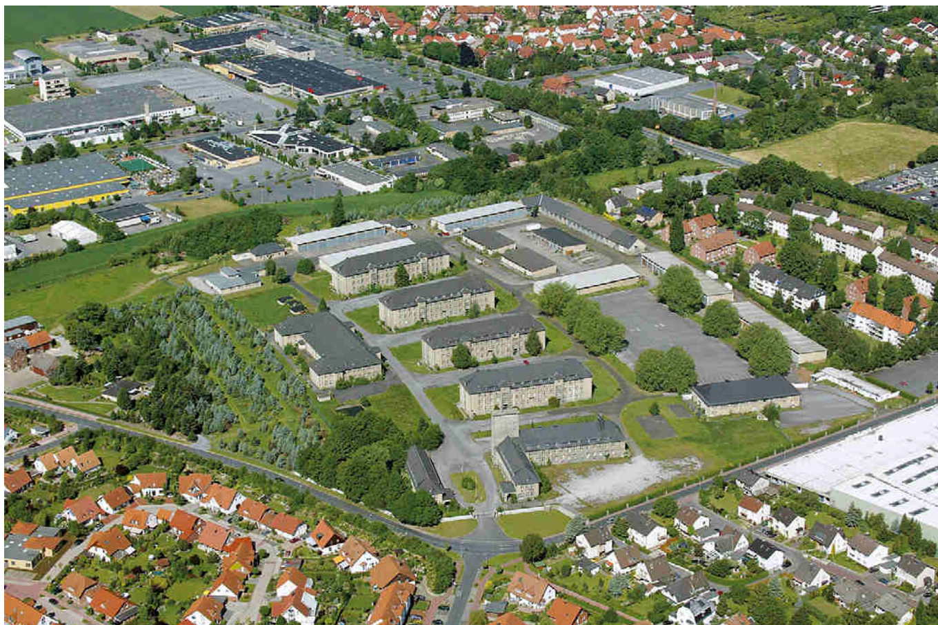
Abb. 8: Block I lag vorne links neben dem Eingang und außerhalb des Lagerzauns
